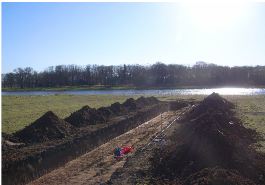
Afb 1.1 Sfeerfoto, werkput 26 richting het westen.
